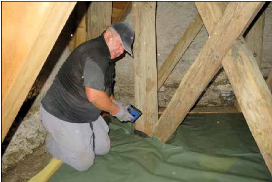
Josef Stroj beim Einbau einer Folie als Schutz vor Fledermauskot in der Kirche St. Egyden, Kärnten. © Klaus Krainer
