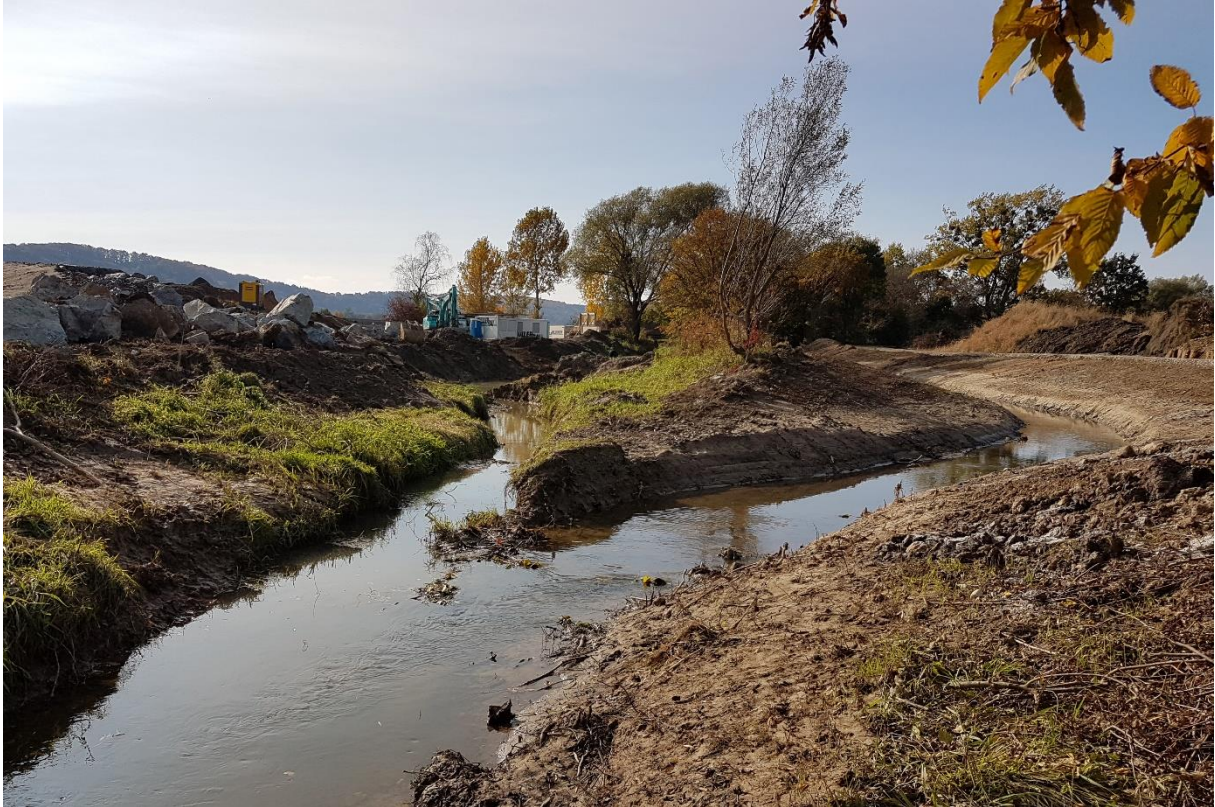
Abbildung 37: Die Baustelle der S7 „Fürstenfelder Schnellstraße“ am Hühnerbach bei Altenmarkt
