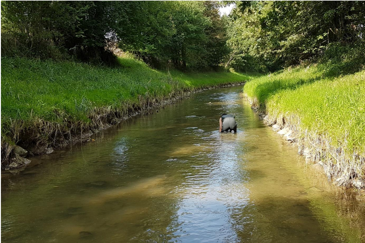
Abbildung 66: Gnasbach bei Hofstätten
