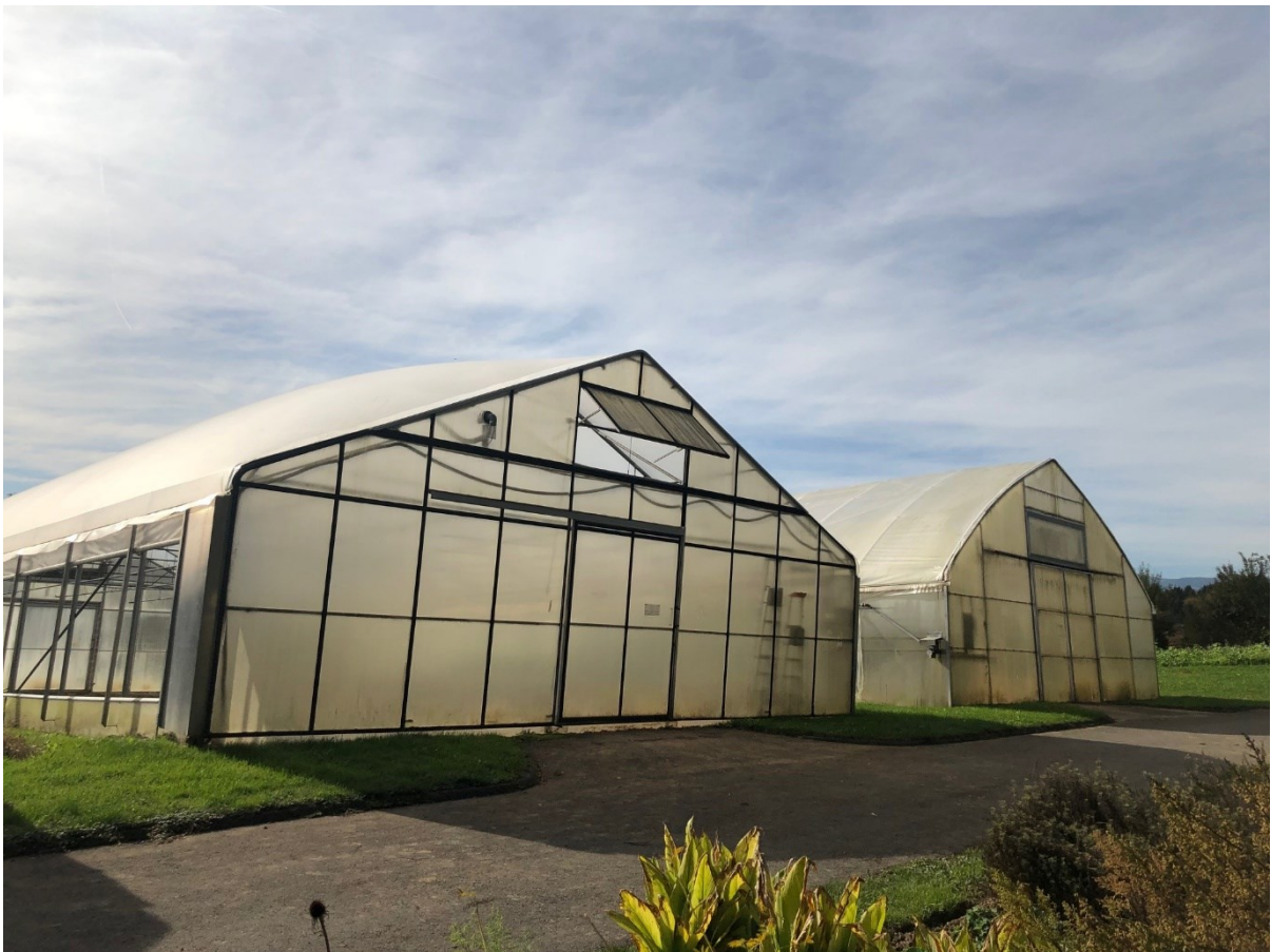
Abbildung 88: zwei baugleiche Folientunnel VST
