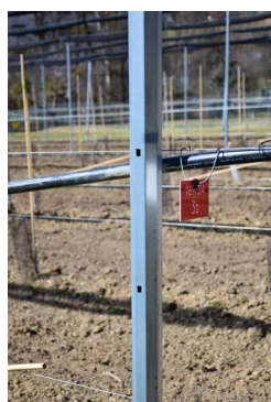
Die leichten achteckigen Stahlsäulen der Firma Trellex; www.trellex.com wurden im neuen Birnenquartier zur Erstellung des Stützgerüsts verwendet.
